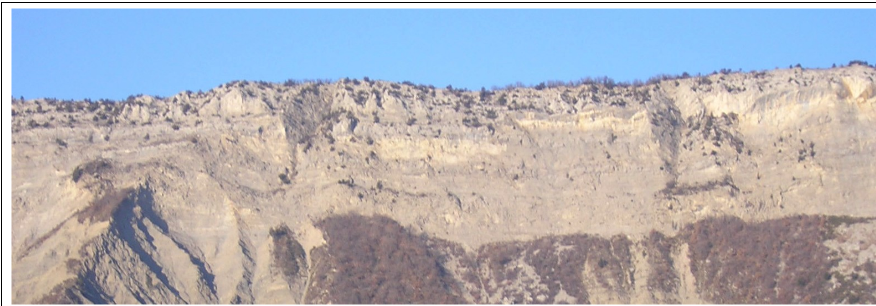
Fig.9: Vue de la barre calcaire du Jurassique supérieur
