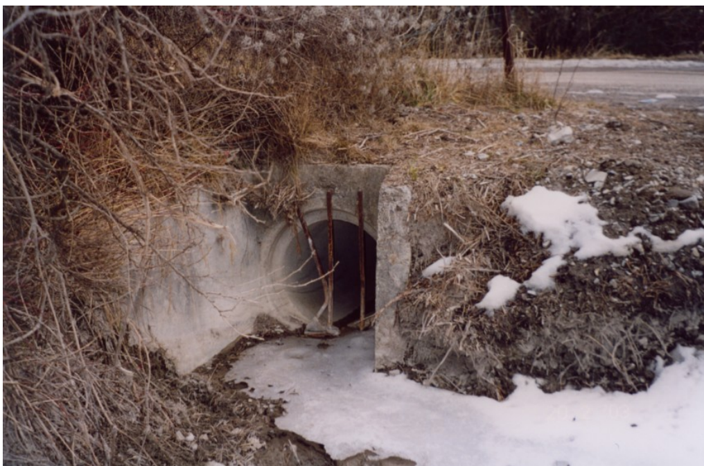
Photo 7 – Passage busé du torrent du CHIEÏ à la sortie du lotissement
