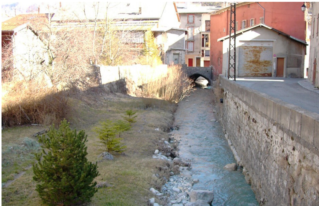
Photo 9 – Vue depuis l'amont du passage souterrain du torrent de GLAIZETTE sous le village
