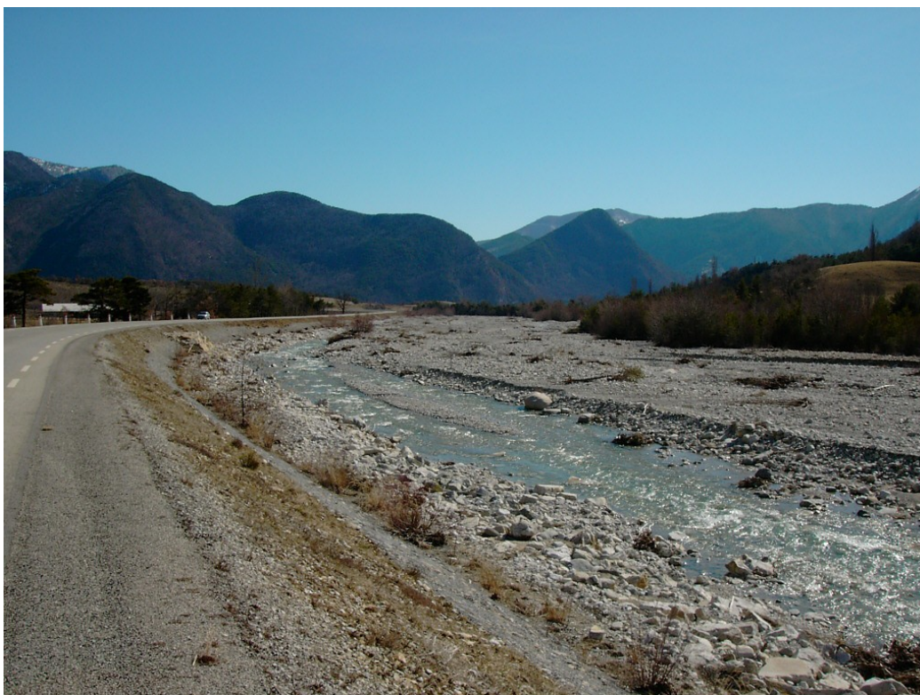
Photo 20 – Enrochement en rive gauche de la BÉOUX afin de protéger la RD 937
