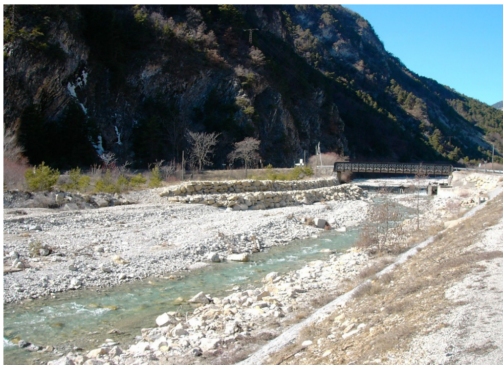
Photo 21 – Enrochement en rive droite de la BÉOUX afin de protéger la station de pompage
