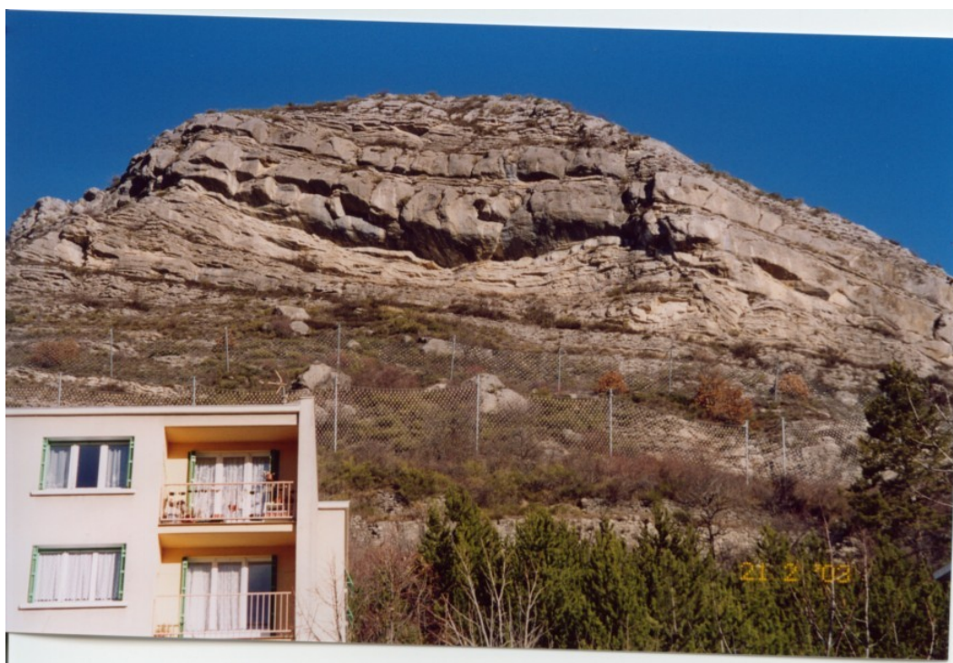
Photo 13 – Site de PIERRE BOMBARDE, avec ses filets de protection et les immeubles exposés
