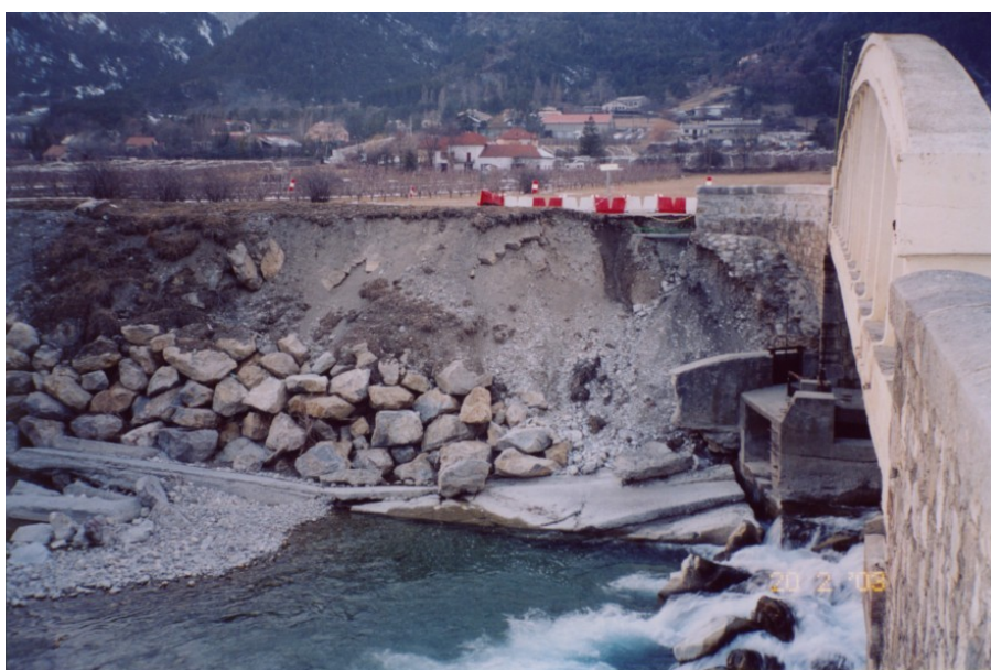
Photo 3 – Vue de la rive droite du PETIT BUECH à l'aval du pont des SAVOYONS
