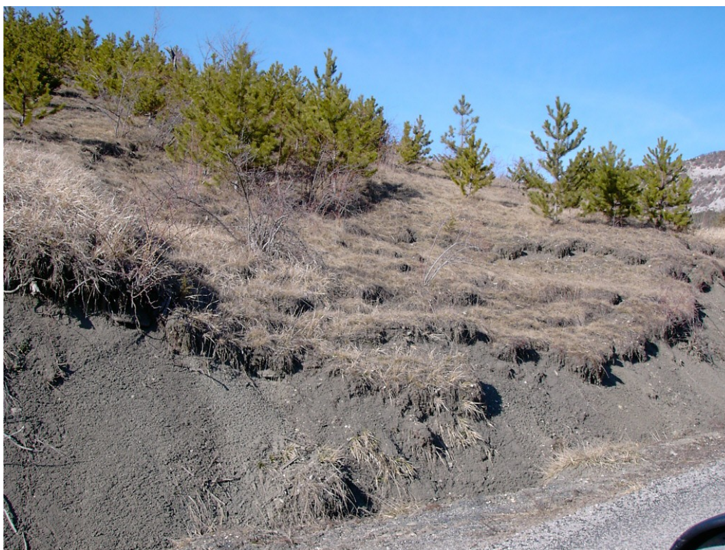
Photo 10 – Glissement dans le talus de la route qui mène au hameau de GLAISE
