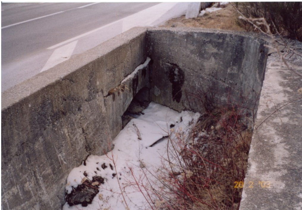
Photo 6 – Passage busé du torrent du Chieï sous la RD 994g
