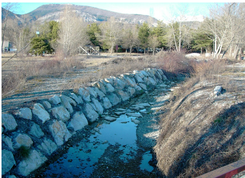
Photo 25 – Enrochements sur le lit du torrent de SAINT MARCELLIN au niveau des campings
