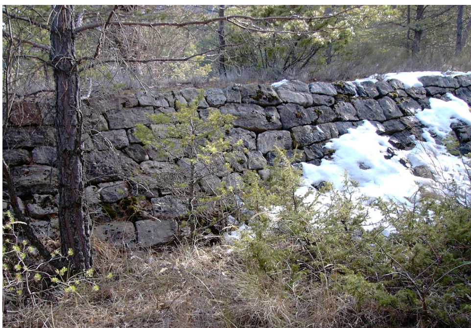
Photo 27 – Digue de protection en rive gauche du torrent du PETIT VAU
