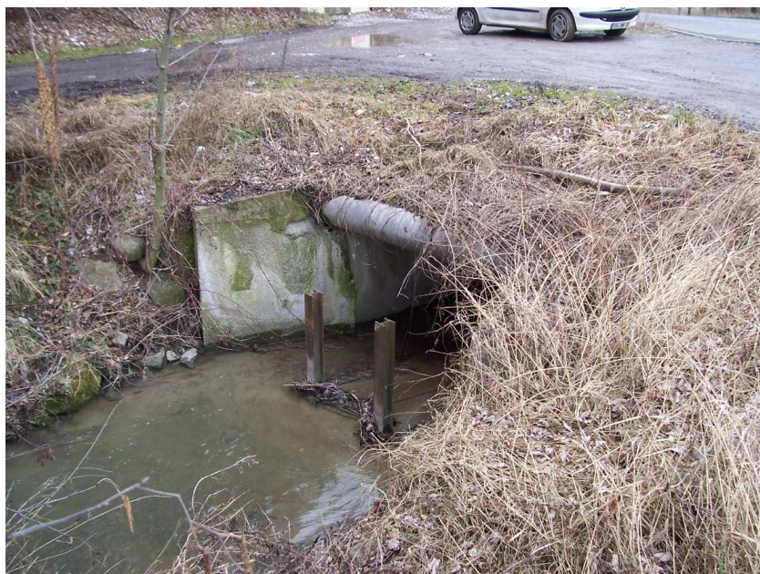
Le pont des Fauvins, vu de l'amont
