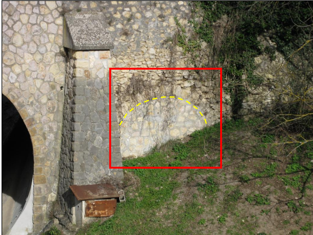
Figure 49 : Torrent d'Albiosc, passage sous la RD 82 (détail d'une arche, désormais murée, de l'ancien pont) [Source : IMS RN ]
