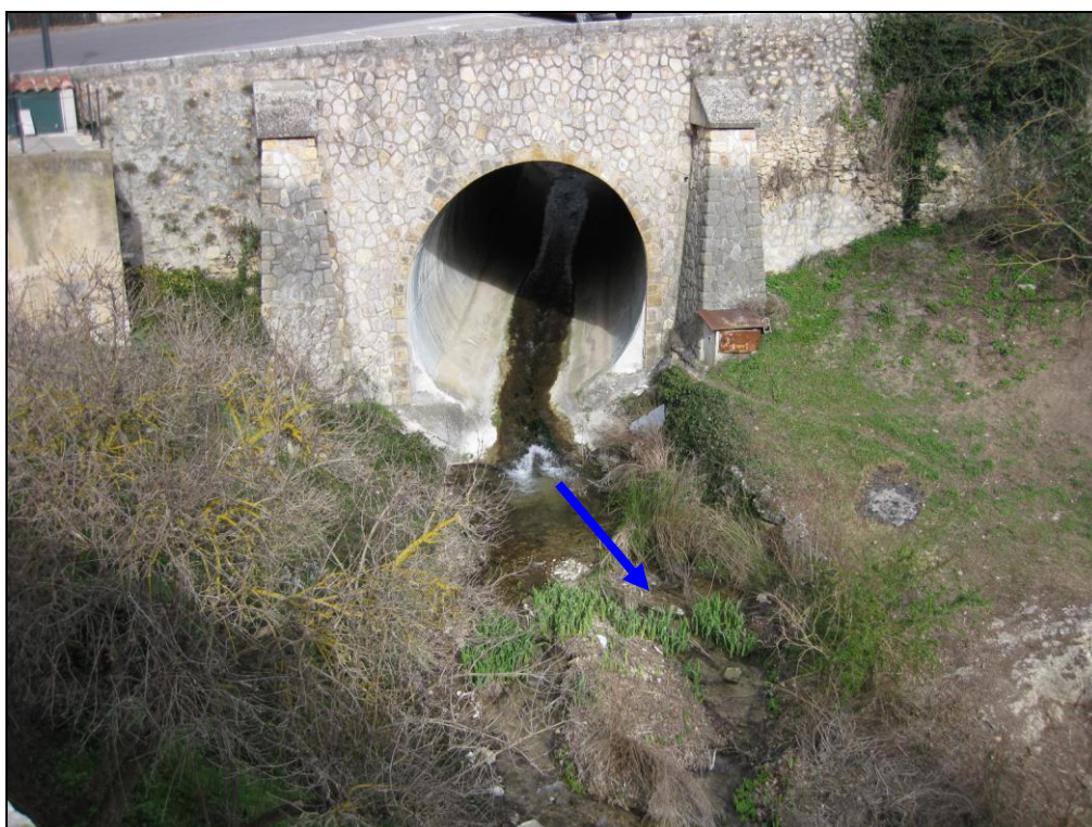
Figure 48 : Torrent d'Albiosc, passage sous la RD 82 [Source : IMS RN ]
