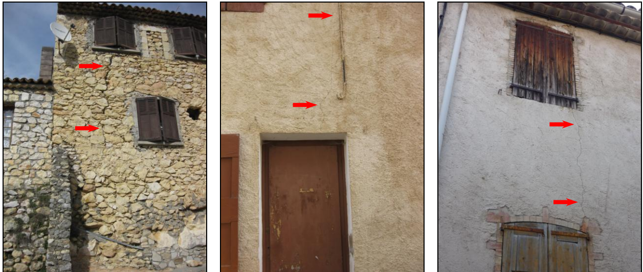
Figure 35 : Fissures sur des maisons, secteur de la rue Sainte-Anne [Source : IMS RN ]
