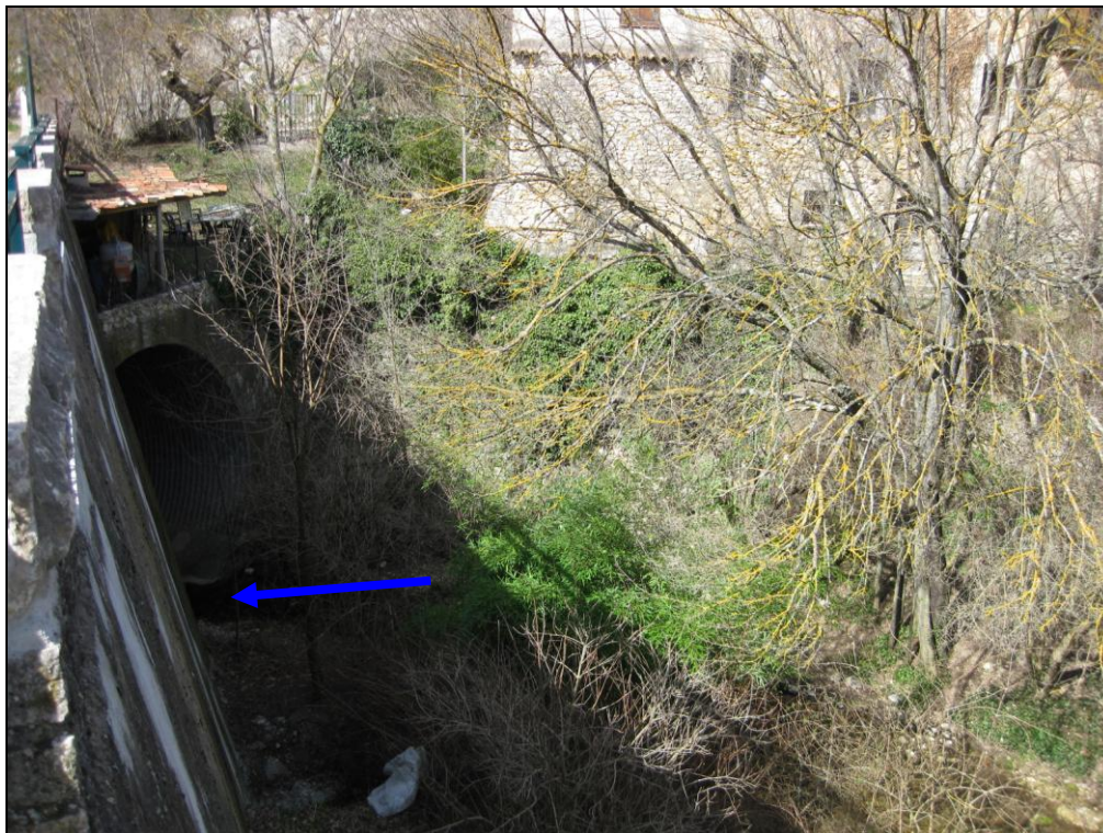
Figure 47 : Torrent d'Albiosc, passage sous la RD 82 [Source : IMS RN ]
