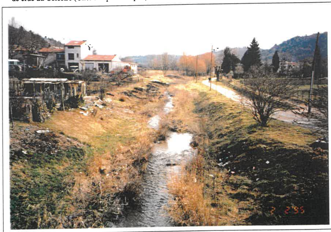
☞ Photographie n°6 Le Colostre à l'amont du Pont Jacquet, vu de l'aval vers l'amont. La capacité du chenal est insuffisante (Cliché Alp'Géorisques).
