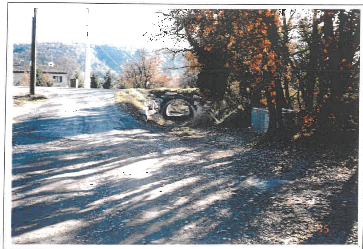
☞ Photographie n°11 L'ouvrage assurant la traversée du ravin de Prayon par le CD 6 vu de l'amont vers l'aval (Cliché Alp'Géorisques).
