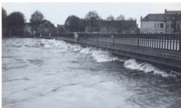
Crue de 1940 - Pont du Châtelet
