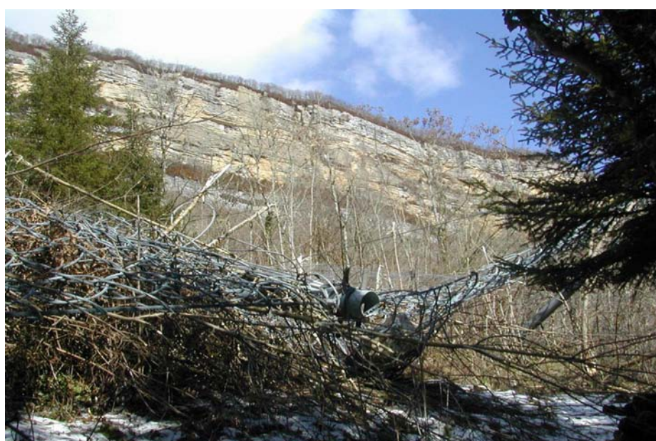
Filet de protection détruit
