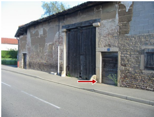
Repère de crue, chemin des Dîmes
