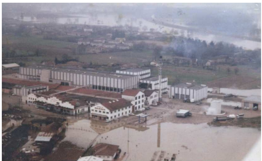
Fromagerie BRESSOR route de Pont-de-Veyle Crue de décembre 1981 (crue d'occurrence vingtennale à trentennale)
