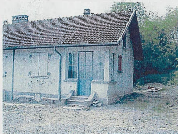
Figure 6 : Habitation partiellement évacuée de la rue de Saint-Jean.
