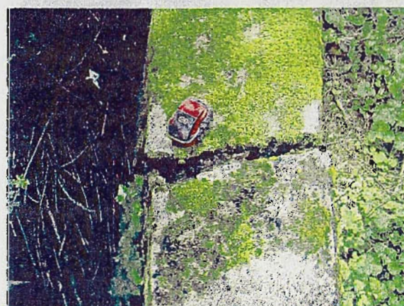
Figure 5 : Fissures observées sur l'école, sur une cabane située à proximité et sur le mur de soutènement de la cour.
