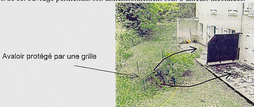
Figure 15 : Rez-de-jardins menacés par les débordements torrentiels du nant des Nais.
