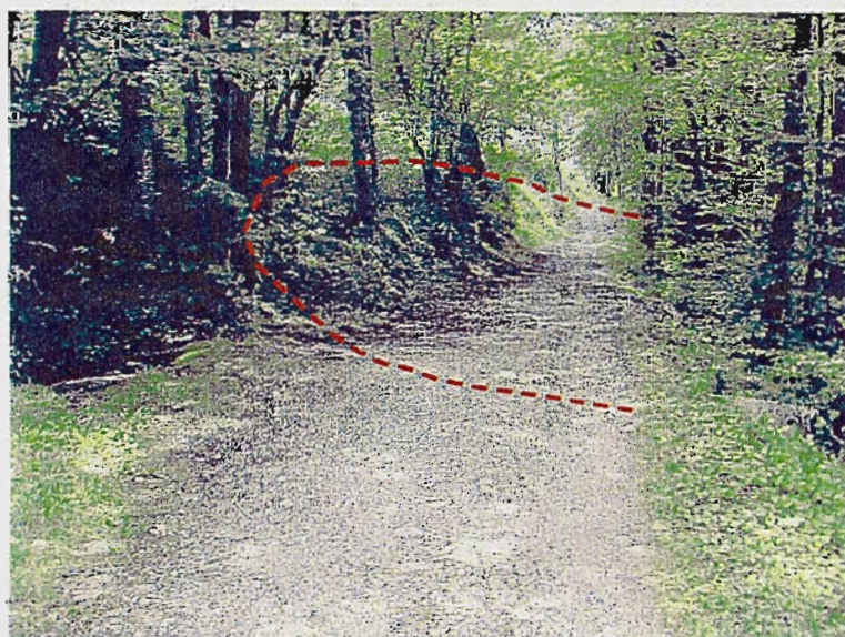
Figure 12 : exemple d'affaissement observé le long de l'ancienne voie du Tramway.
