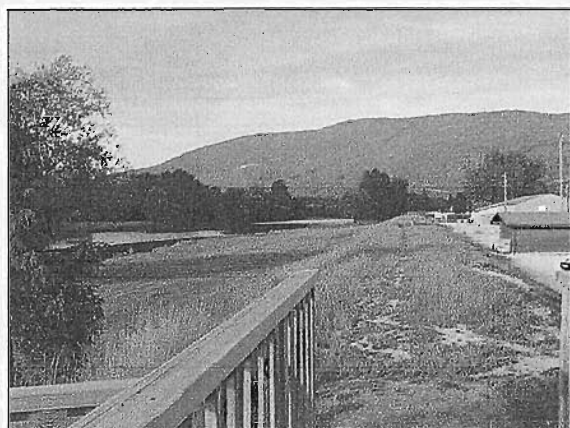
Bienne : digue de la Bienne depuis la confluence avec le Merdanson
