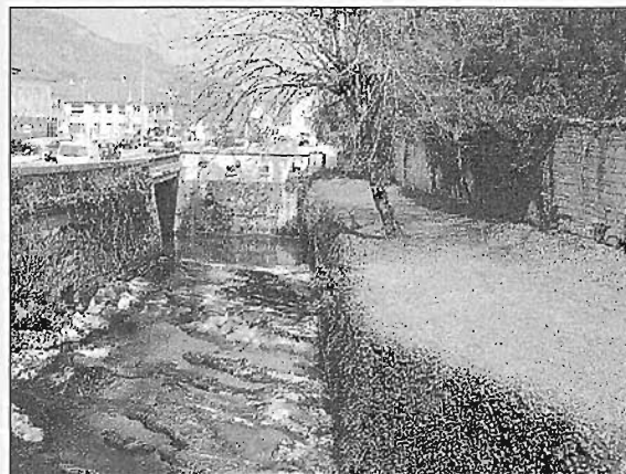
Merdanson : Pont sur la RD31 vue amont
