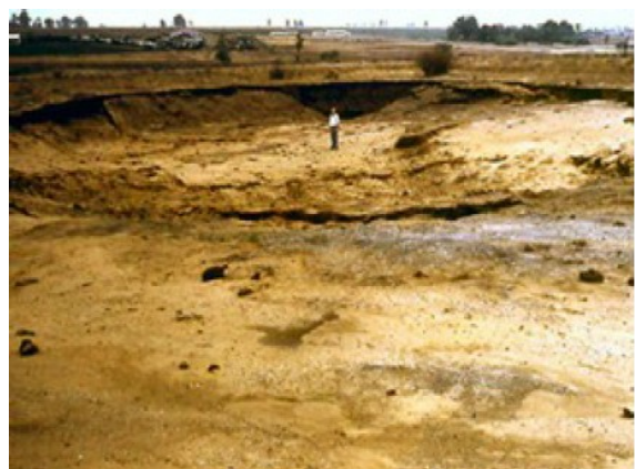
Photo 5 : Effondrement généralisé
