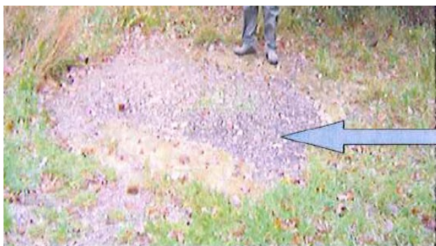
Photo 1 : Constat de la fermeture de la cheminée RA5 (janvier 2009)
