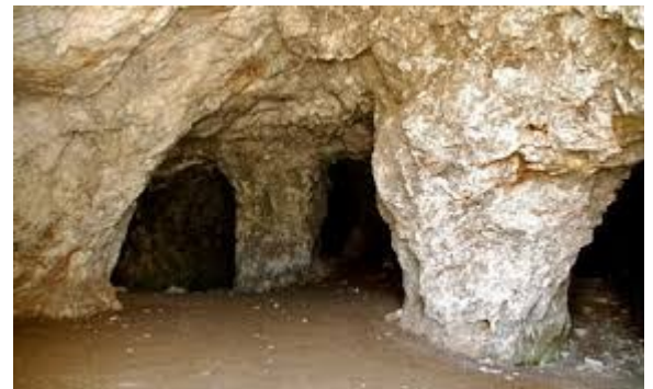
Photo 3 : exemple de chambres et piliers
