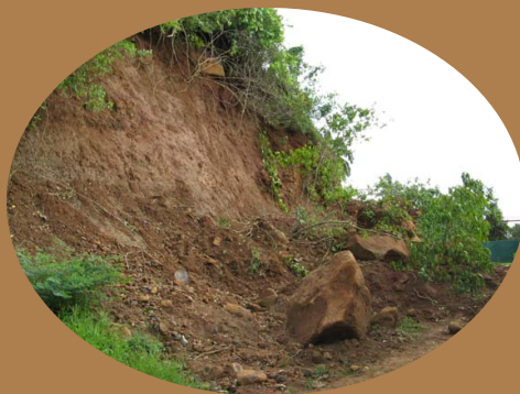
Chutes de blocs rocheux après les fortes précipitations survenues en 2008 (source : BRGM)
