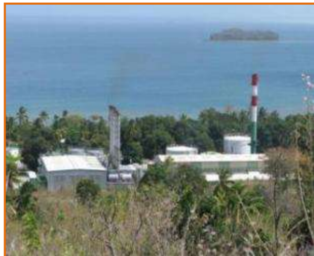
Vue sur la centrale des Badamiers.
