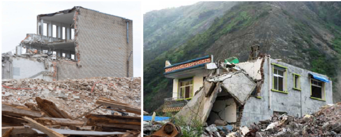
Exemple de tremblement de terre
