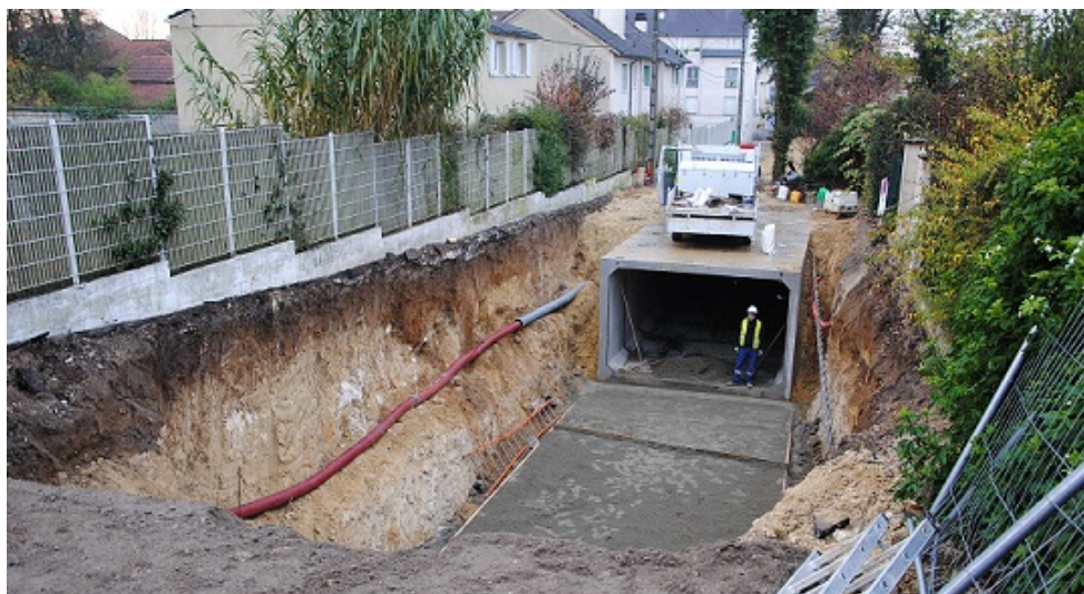
Chantier du bassin de retenue des Jollies (2010)
