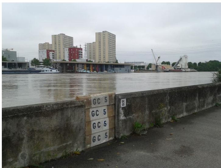
Murette fermée par un batardeau lors de la crue de juin 2016
