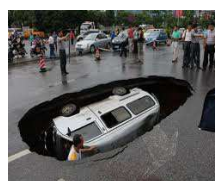
Exemple de fontis sous chaussée.
