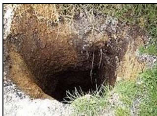
Mouvement de terrain (cavités souterraines)
