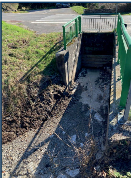
Passage couvert du ruisseau du Béguin
