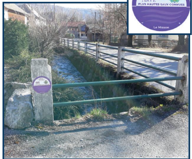
Repère de crue installé au Pont Faitaman à Saint-Jeire
