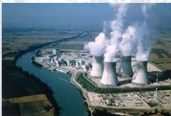
Centrale nucléaire du Bugey (Ain)
