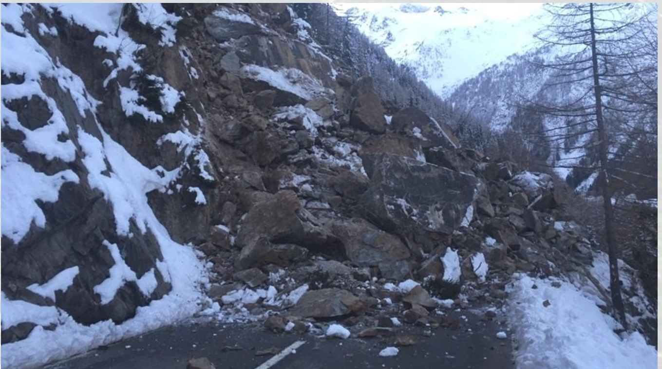
Illustration : éboulement du col de la Forclaz, janvier 2018 Crédits : lenouvelliste.ch
