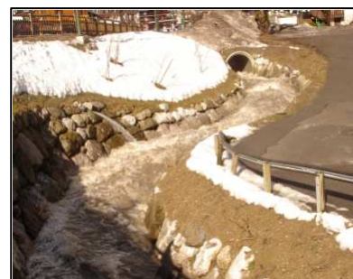
Enrochements de berge sur le Nant
