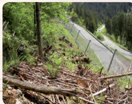
Filets pare-pierres dans le Col de Morgins.
