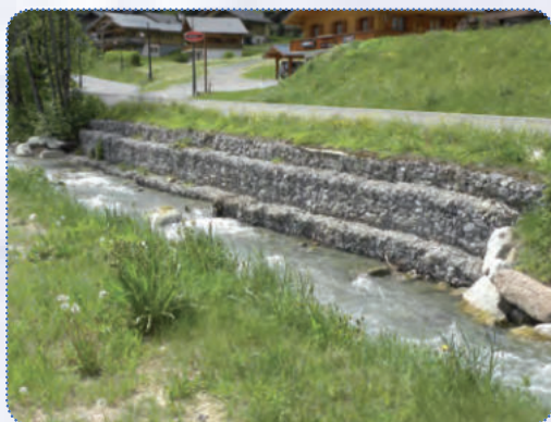
Mesure de protection : gabions dans le secteur du Linga (route de Pré-la-Joux).
