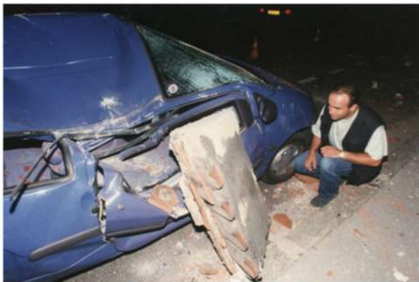
Cheminée tombée sur le toit d'une voiture suite au séisme d'Annecy, le 15 juillet 1996
