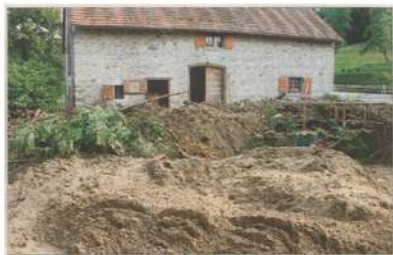
Maison du hameau des Biolles engloutie par les dépôts de la crue du 4 juillet 2007.
