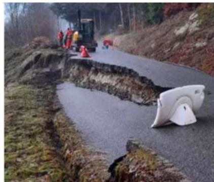
Effondrement d'une portion de la chaussée de la route des Voirons (D50)
