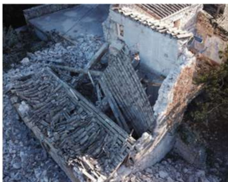
Séisme du Teil – Habitation endommagée à la Rouvière, 11 novembre 2019
