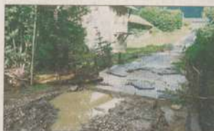
Le pont des Perriers à Bodge est détruit.
