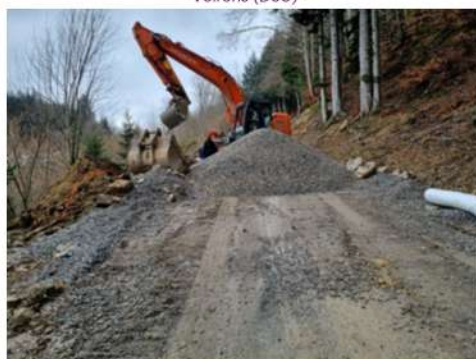
Réfection de la chaussée effondrée avec l'installation de plusieurs tonnes de gravier
