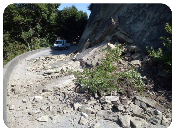
..... Eboulement survenu le 06/08/2020 Route de Mûres
