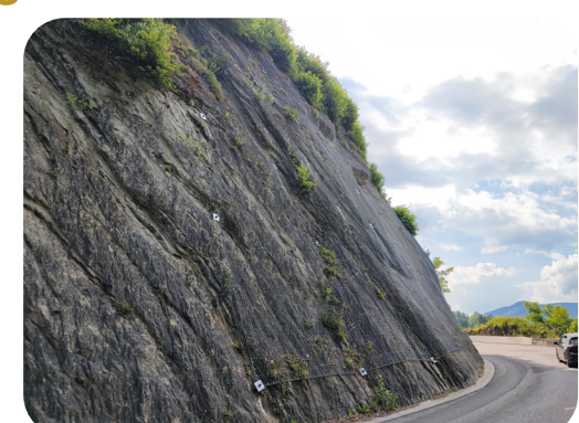
Filets de protection contre les chutes de pierres suite à l'éboulement survenu le 06/08/2020 - Route de Mûres
