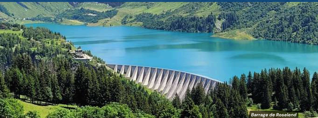
Barrage de Roselend
