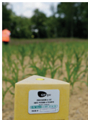
Borne matérialisant le passage de la conduite
