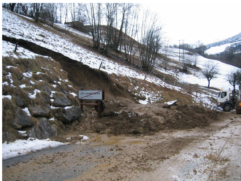
Glissement de terrain saturé d'eau Voie communale, La Couerbaz
