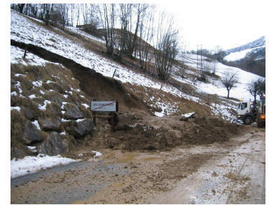
Glissement de terrain saturé d'eau au chef-lieu.
