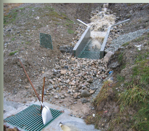
La grille évite les transports solides.
