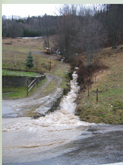
Ruisseau de la Grange. Les buses ont été redimensionnées et le chenal conforté.
