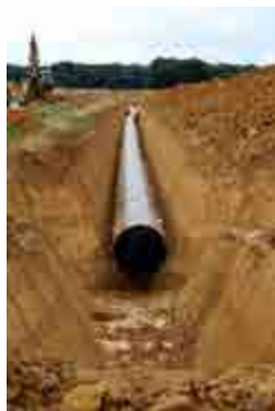
Installation d'un gazoduc enterré
