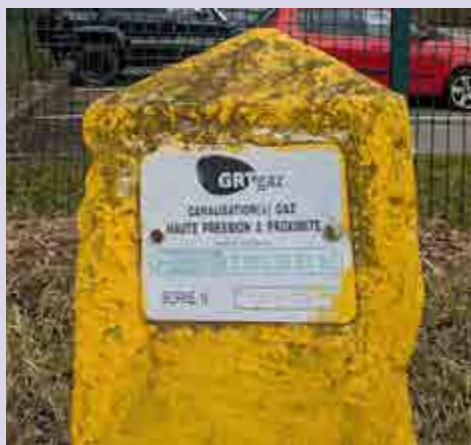
Borne signalant le passage sous-terre d'un gazoduc
