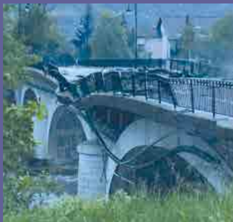
Dégâts du pont Albertin suite à l'explosion liée à une fuite de gaz combinée à un incendie le 13 mai 2018
