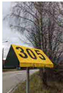
Balise signalant le passage sous-terre d'un gazoduc
