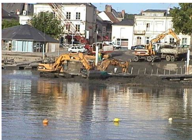
Travaux de désenvasement durant les écourures de la Sarthe et de réfection du quai du port de Sablé en 2007
