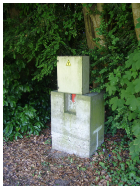
En extérieur : poste électrique E.D.F. surélevé situé dans le Parc du Château en bordure de la Vaige (zone inondable)
