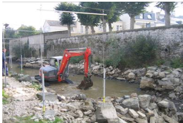
Exemple d'enrochement des berges bordées par des murs d'habitations dans le bras de la Marbrerie
