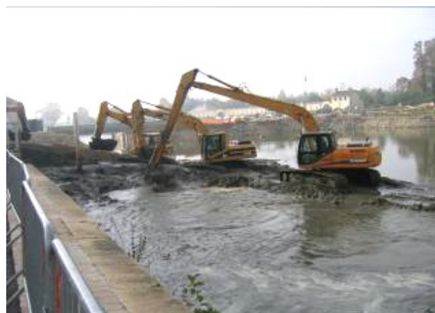
Travaux de désenvasement durant les écourures de la Sarthe et de réfection du quai du port de Sablé en 2007
