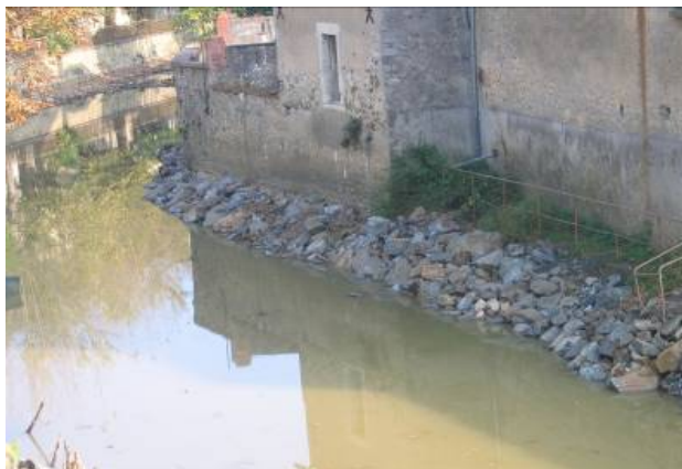
Exemple d'enrochement des berges bordées par des murs d'habitations dans le bras de la Marbrerie
