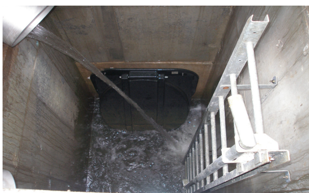
Exemple de poste avec clapet anti retour à la Flèche
