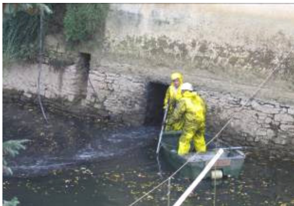
Travaux de nettoyage et de rejointement sous la Mairie
