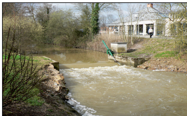
Barrage à clapet situé à la confluence de la Vaise avec la Sarthe près du CREPS de Sablé
