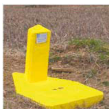
Balise jaune de signalisation de conduite de gaz
