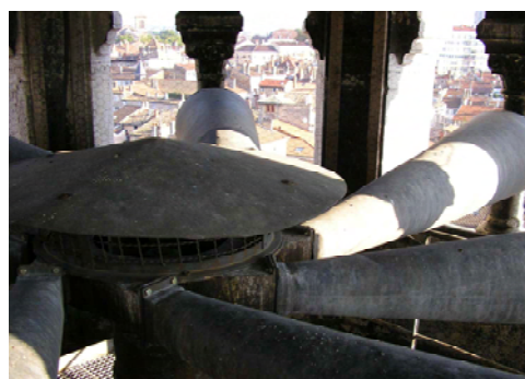
Sirène du réseau national d'alerte
