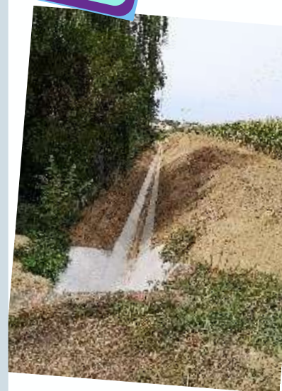
TRAVAUX FOSSÉ "V7"
