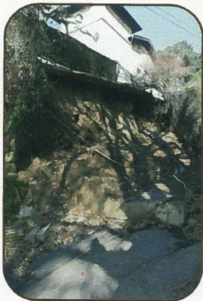
Effondrement d'un mur de soutènement Route de Saint André
