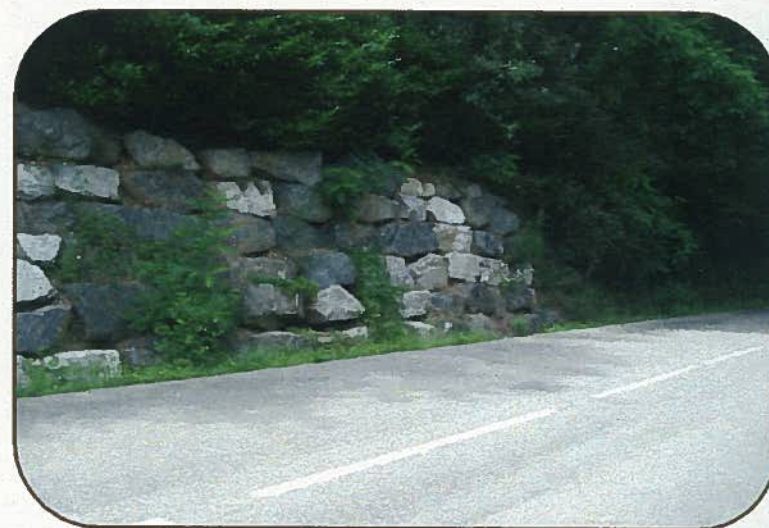
Enrochement réalisé sur la RD 65
