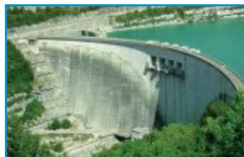
Barrage de Vouglans, Jura.
