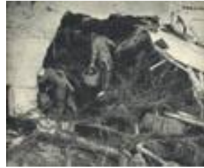
Dégâts de la catastrophe de Malpasset
