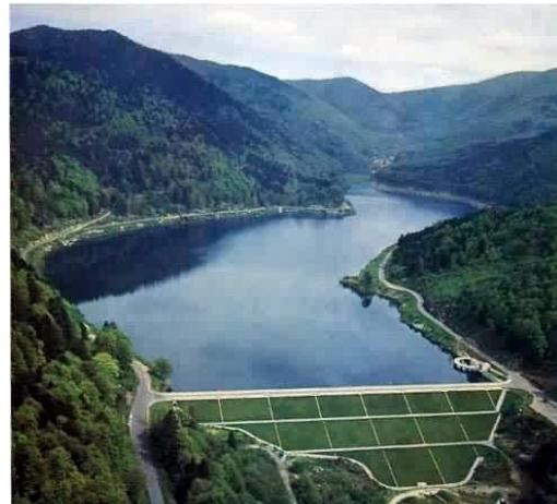
Avec sa contenance de 11,6 millions de m<sup>3</sup>, il fait partie des deux plus grands barrages du Haut-Rhin. C'est un barrage en remblai, dont la première mise en eau date de 1964.
