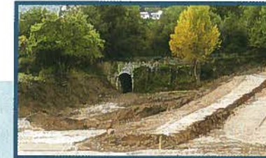
Bassin de rétention – aménagement du lotissement des Tins
