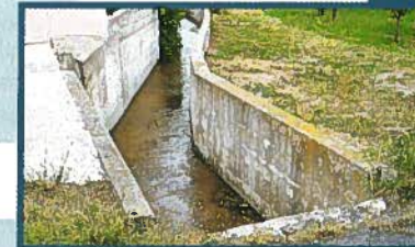
Cuvelage du Ventous
