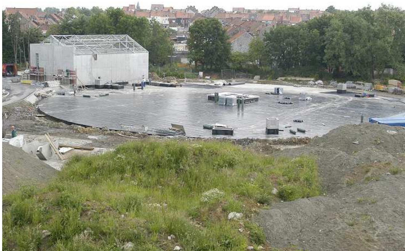
Construction du bassin d'orage du Mont-à-leux
