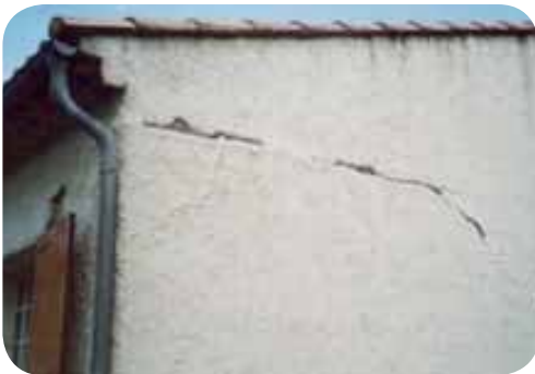
Fissures sur un pavillon suite à un mouvement de terrain.
