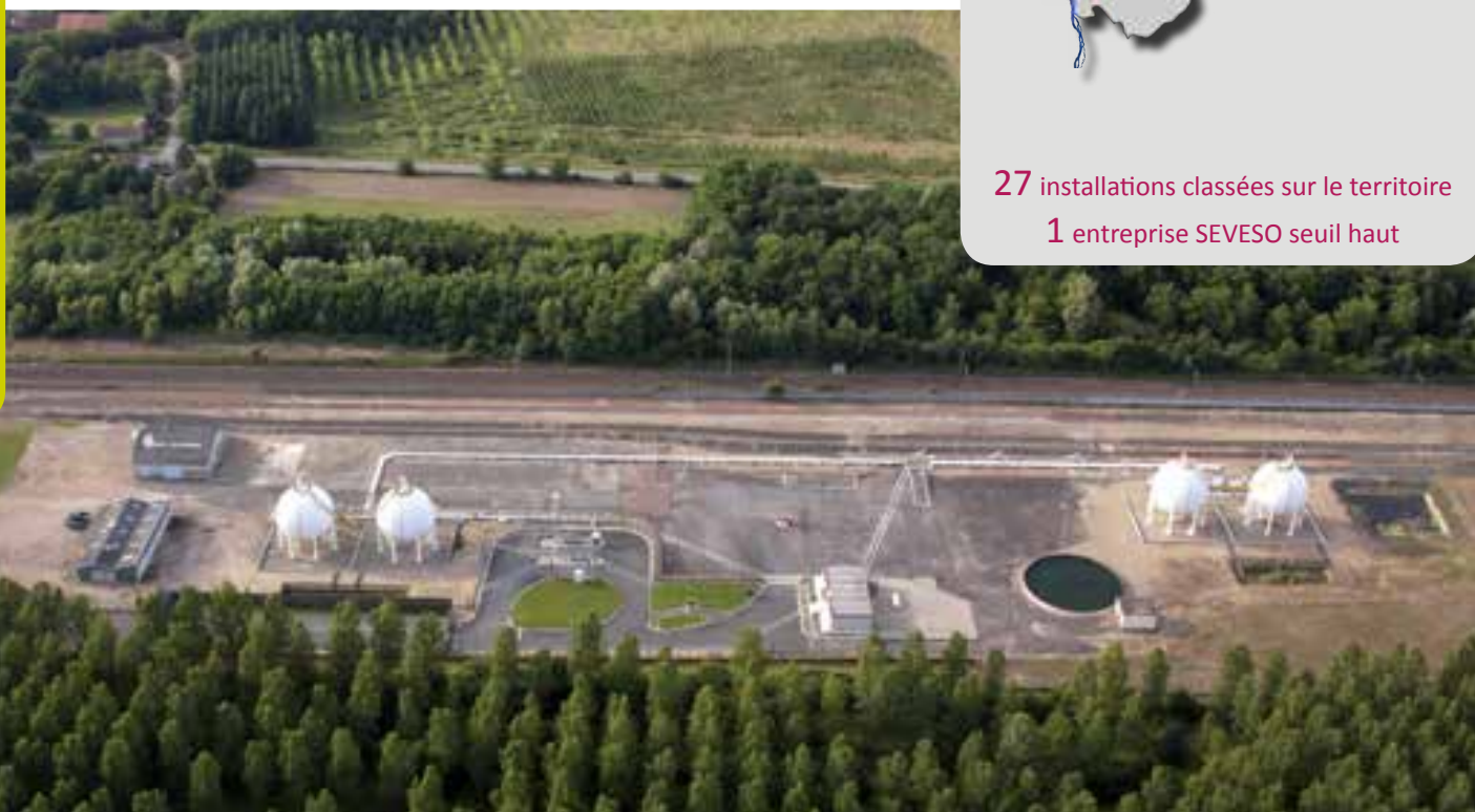
Installations de TOTALGAZ à Gimouille (c) Nevers Agglomération - P. FRANÇOIS
