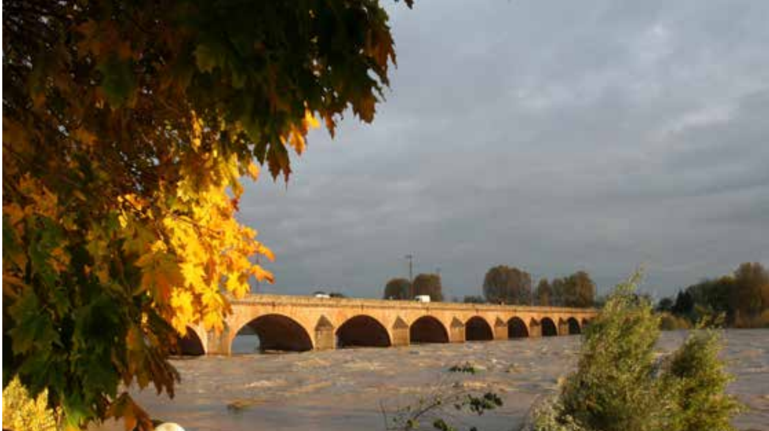
Crue de novembre 2008 - Pont de Loire à Nevers - (c) Patrick Lériget
