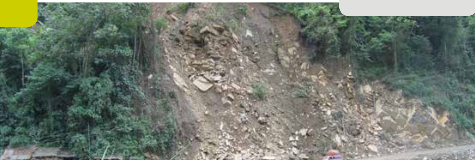
Glissement de terrain (c) IRD
