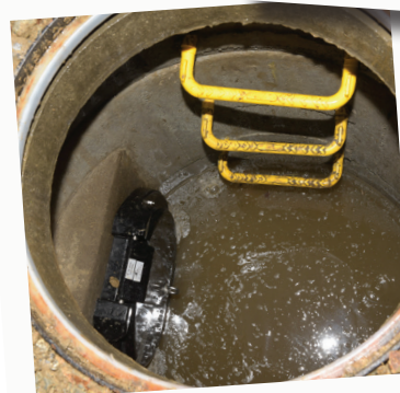
Pose de clapets anti-retour
