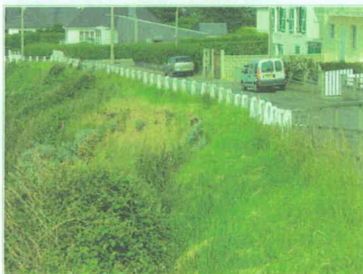
4 : commune de DONVILLE-LES-BAINS , quelques instabilités sont à signaler à l'aval de la rue de LA DOUANE, comme en témoigne la petite zone éboulée au centre de la photo. On notera également les fortes déformations de la chaussée de la rue de LA DOUANE.
