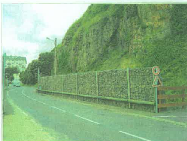
2 : commune de DONVILLE-LES-BAINS , merlon pare-blocs érigé le long de la rue de LA PLAGE. On notera l'état de fracturation avancé de la roche laissant présager de nouvelles chutes de blocs. Le merlon protège la chaussée et les abords d'un terrain de tennis.
