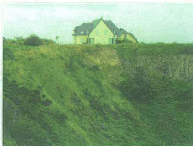
1 : commune de DONVILLE-LES-BAINS secteur des MARES , le rocher était autrefois exploité en carrière. Cette exploitation a laissé la place à une falaise haute de quelques dizaines de mètres générant des chutes de blocs, voire de petits éboulements. Le dernier épisode en date remonte à 2004. La roche est très fracturée et plusieurs niveaux instables laissent présager de nouveaux phénomènes d'éboulement.
