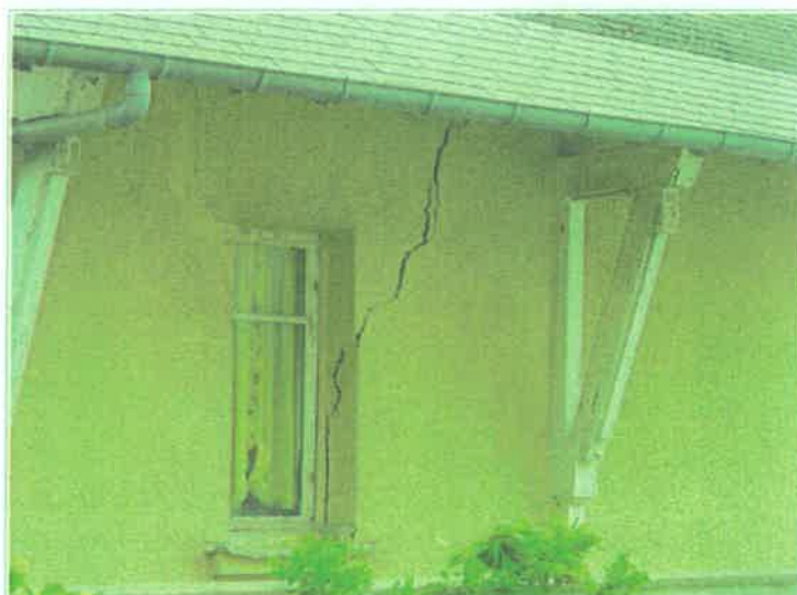
3 : commune de DONVILLE-LES-BAINS , une maison située en tête de coteau au n°25 de la rue de LA CORNICHE présente des fissures importantes sur ses façades latérales pouvant être liées à l'instabilité du terrain par ailleurs constatée (éboulements rocheux au droit des terrains de tennis).
