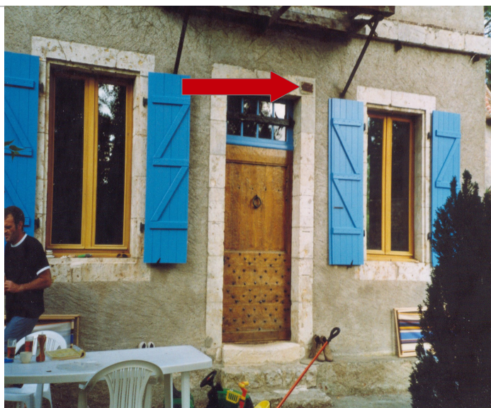
Maison éclusière de Langle
