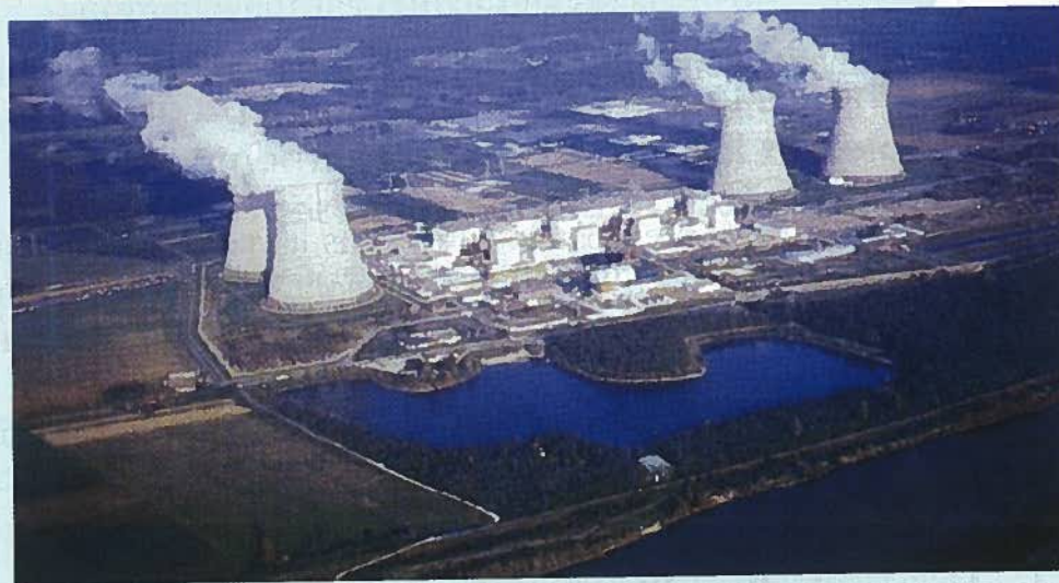
La centrale de Dampierre en Burly
