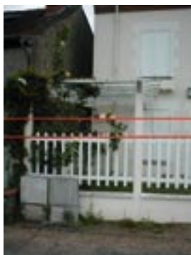
Une maison sur la Pâtache au lieu dit du Port avec indication des niveaux des crues de 1856 et 1866. Les coffrets électriques seraient inondés.
