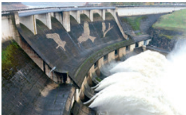
Barrage de Villerest
