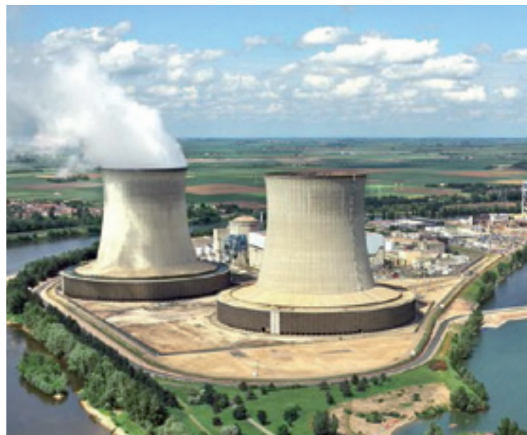
Centrale de Saint-laurent-Nouan
