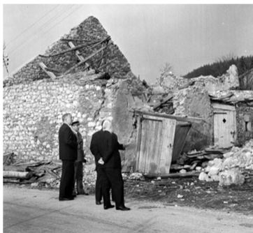
Corrençon-en-Vercors : dégâts suite au séisme du 25 avril 1962
