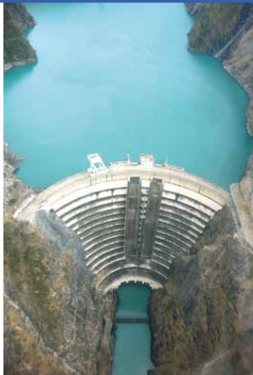
Barrage de Monteynard-Avignonet.
