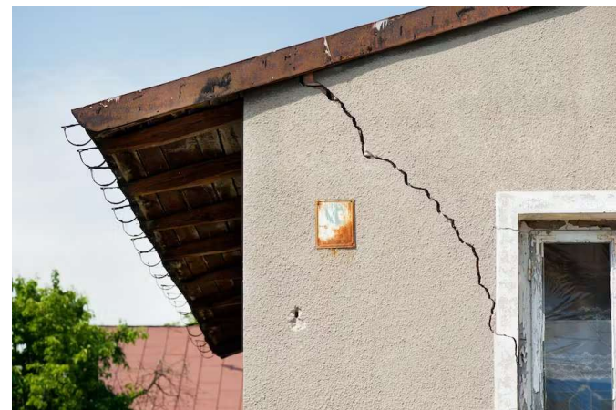
Figure 4. Un exemple de dégât provoqué par le phénomène de retrait-gonflement des argiles.
